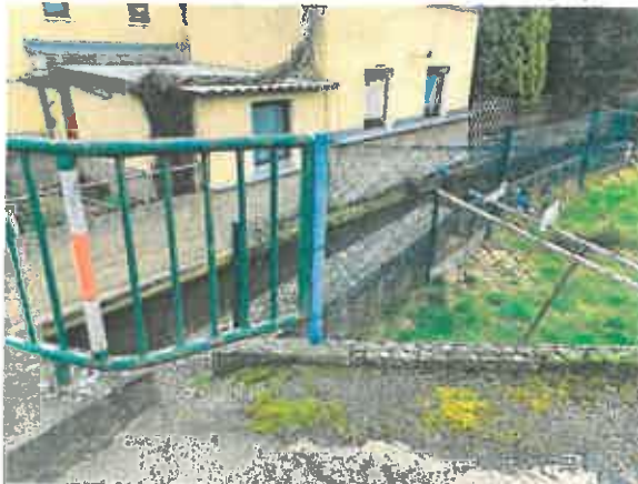
Detail Geländer und Entwässerung vorn, rechts
