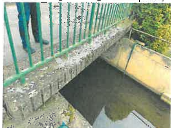
Sicht auf Kappe und Gesims von Oberstrom (Süden)
