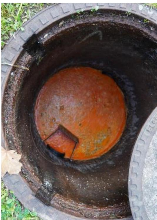
Abbildung 4a: Fettabscheider, Stufe 1
